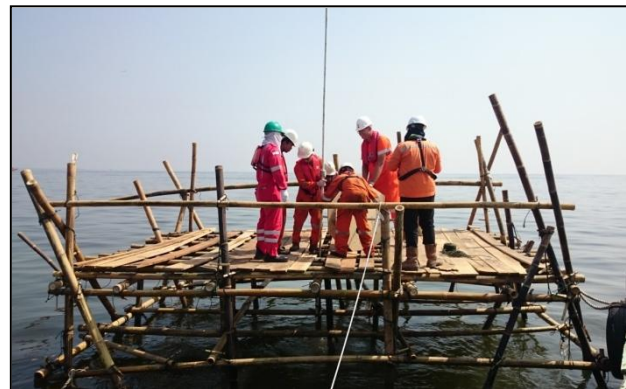
Installatie van een SAAF
